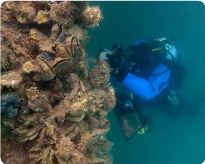
Figura 35: La copertura di organismi bentonici sui pilastri nel Porto di Capodistria.
